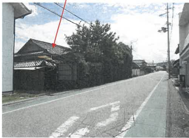
物件9 主である建物
