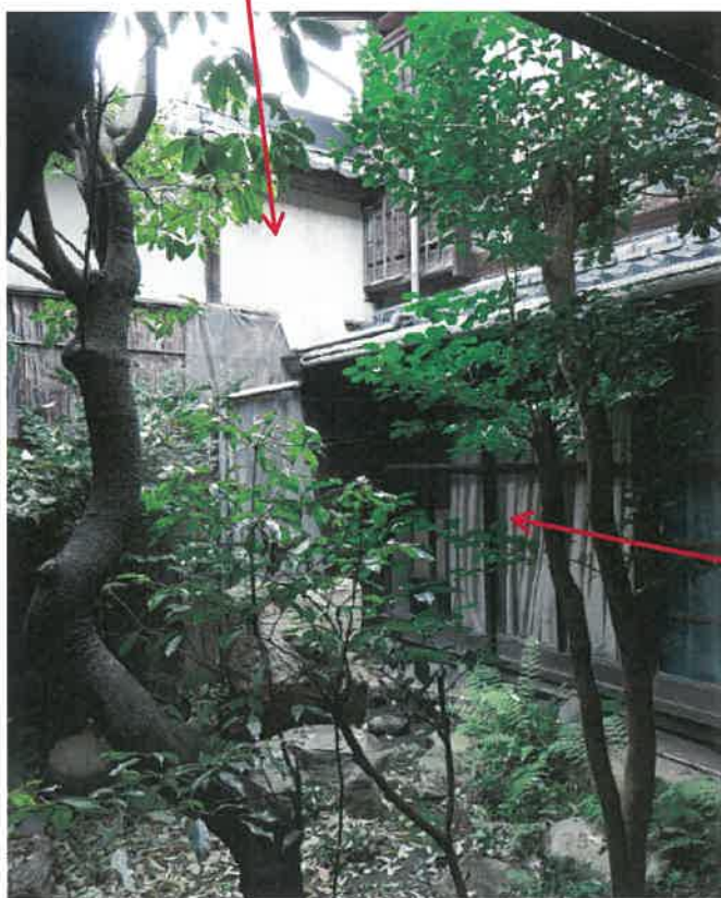
本件建物に接着している北側隣家
