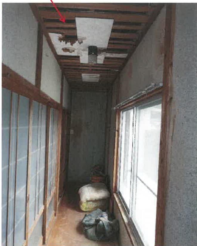
猫による天井の損傷
