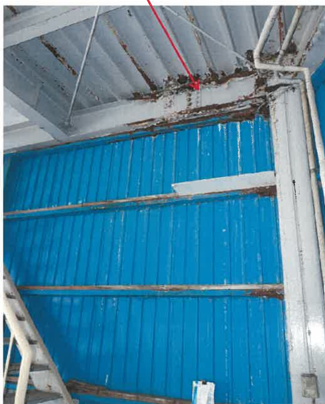
鉄骨の腐食部分
