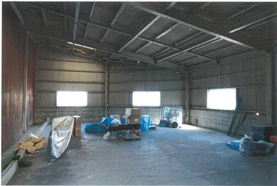
物件7 建物内部
