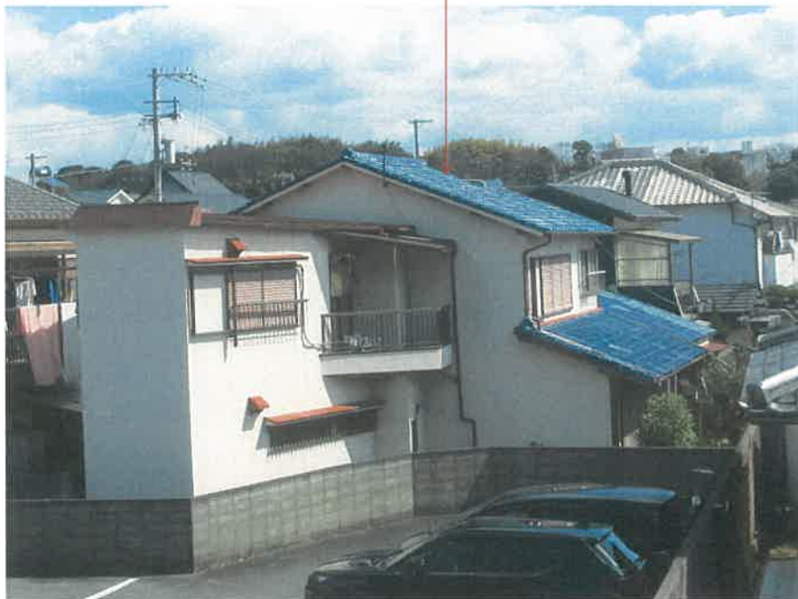
物件2主要建物
