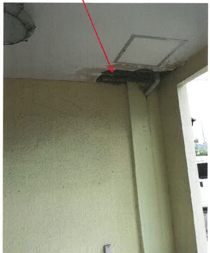
1階店舗 入口付近の底の抜け落ち 写真 ⑥
