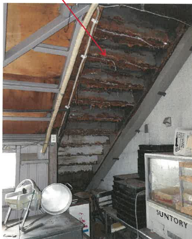
南側外階段の腐食
