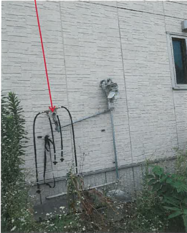
壁から外れた プロパンガスの配管
