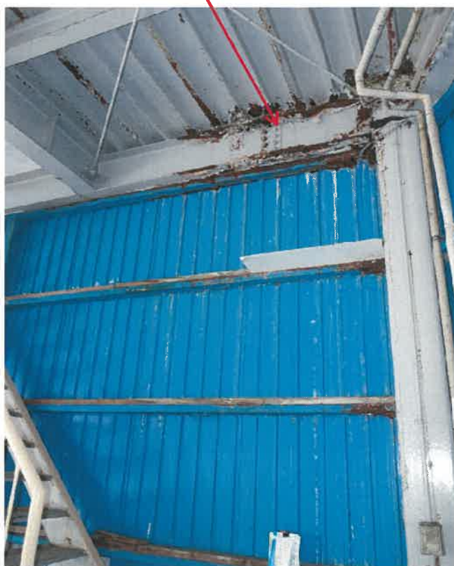
鉄骨の腐食部分
