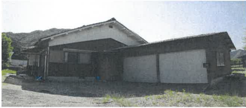
物件 2 主である建物
