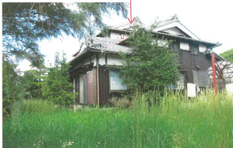
物件3主要建物
