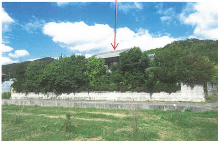
物件3主要建物
