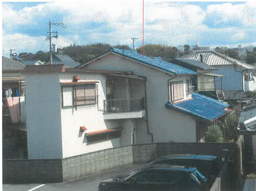
物件2主要建物
