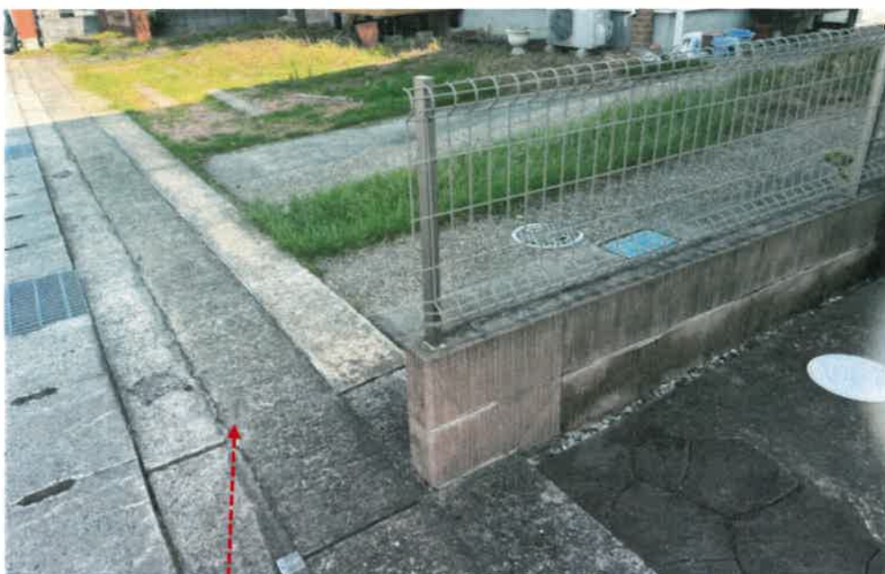
物件4 (用悪水路)
