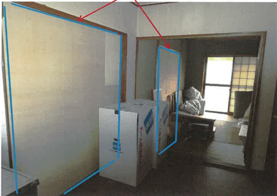
造作した壁の部分(青線の枠内)
