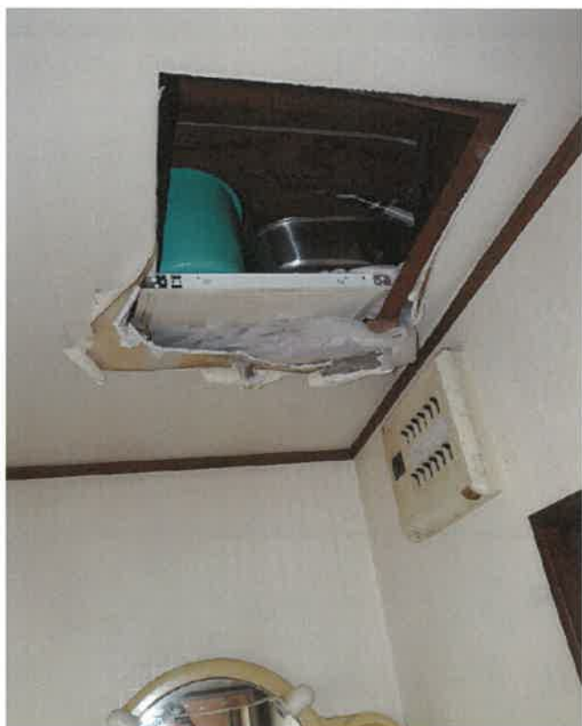
洗面所天井裏の水漏れ部分
