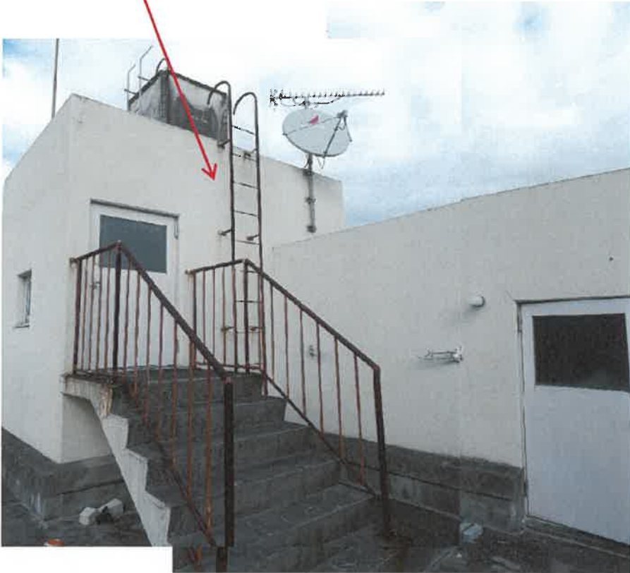
塔屋 エレベーター機械室
