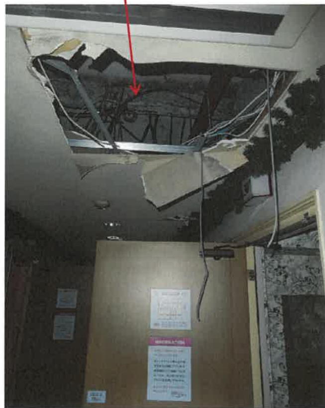
307号室前天井の破損
