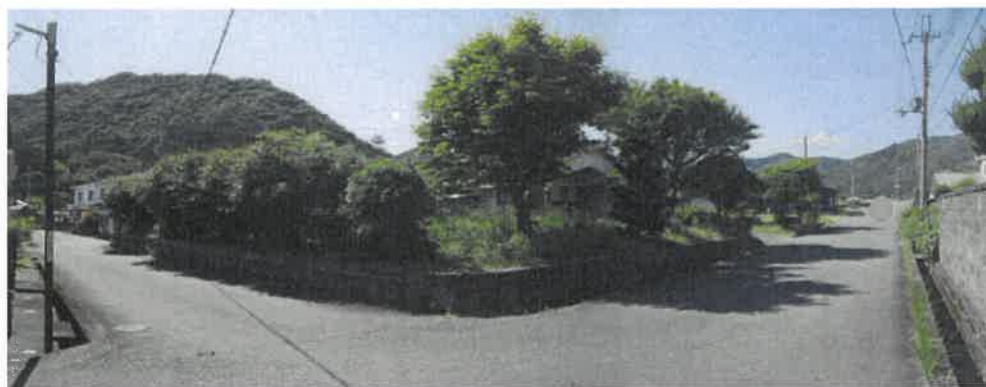
物件2主である建物
