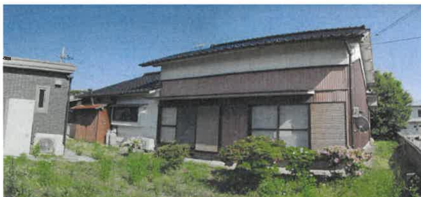
物件2主である建物
