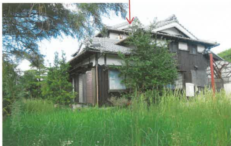
物件3主要建物
