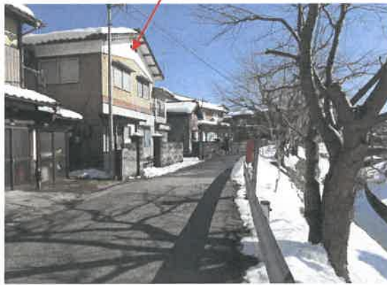
物件2 主である建物
