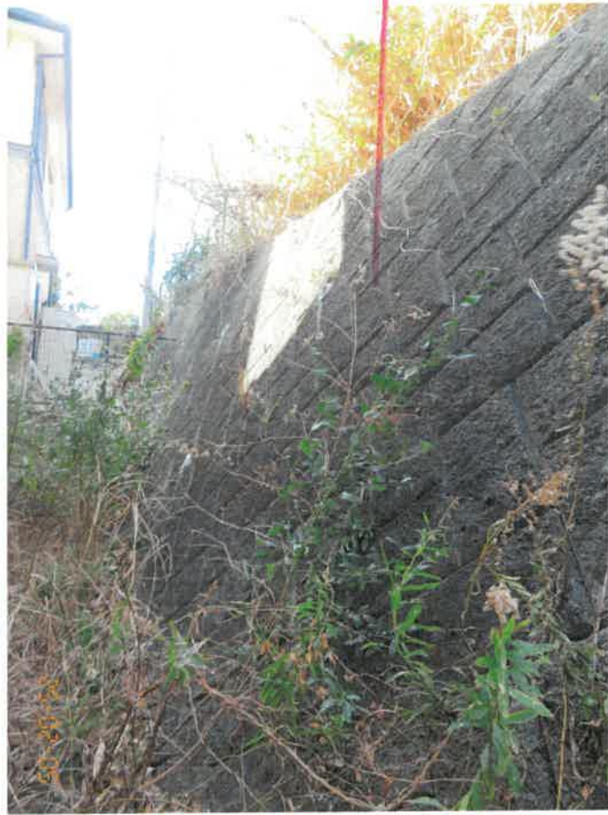
コンクリート擁壁の高さ約3m
