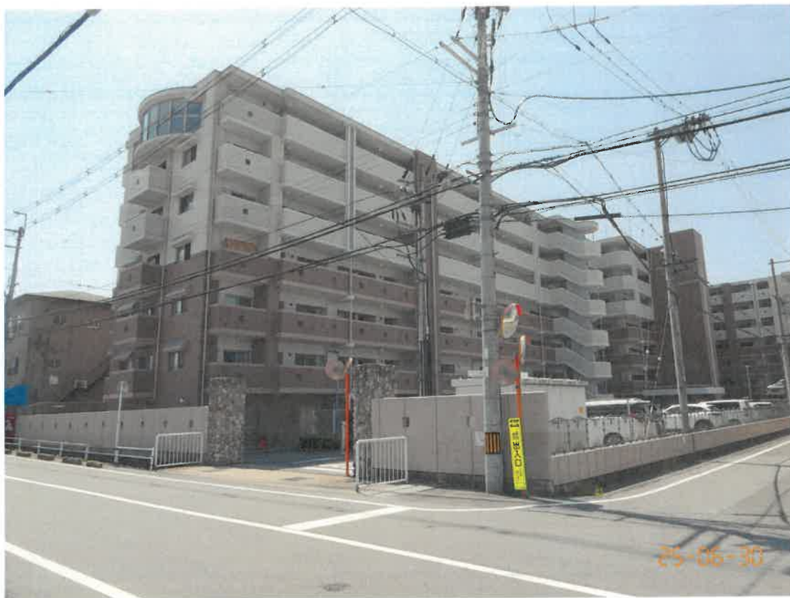
一棟の建物全景
