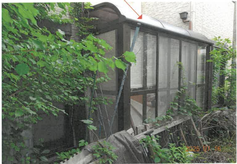
⑦ (未登記増築部分：サンルーム)
