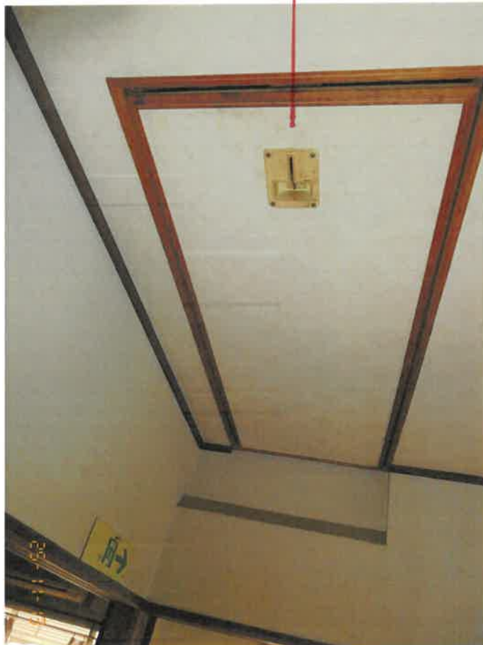
屋根裏収納の入口
