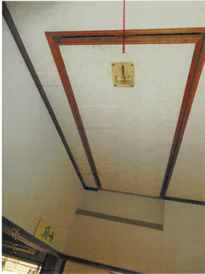
屋根裏収納の入口
