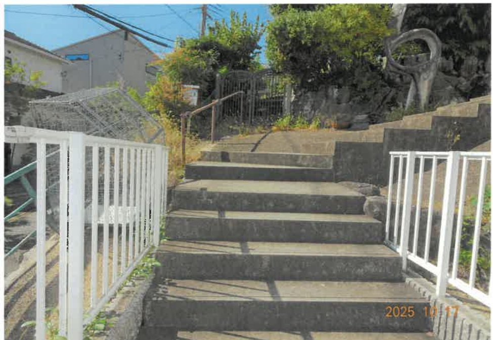
⑯ (南側出入口へ通じるコンクリート製階段)
