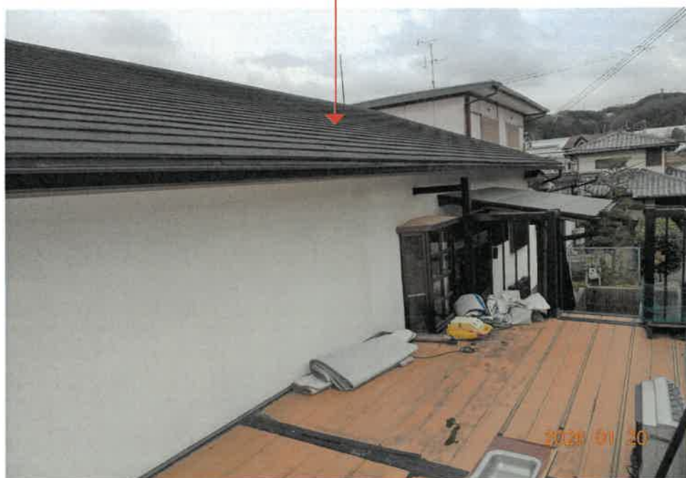
② (スレートに葺き替えられた屋根)
