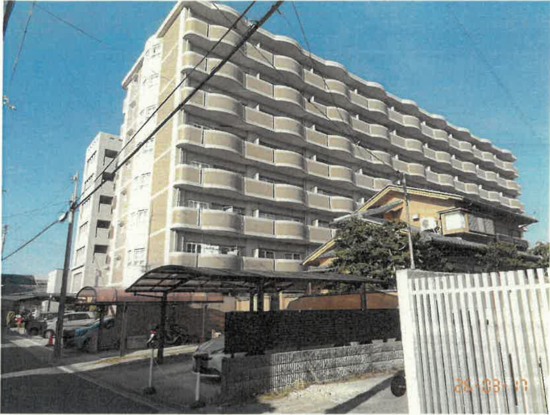
一棟の建物全景
