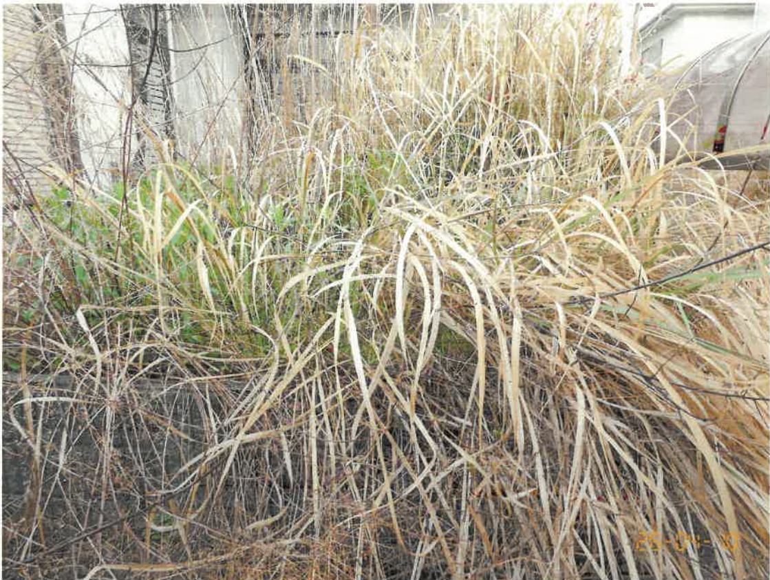
門扉から玄関に至るところに繁茂している雑草の状況
