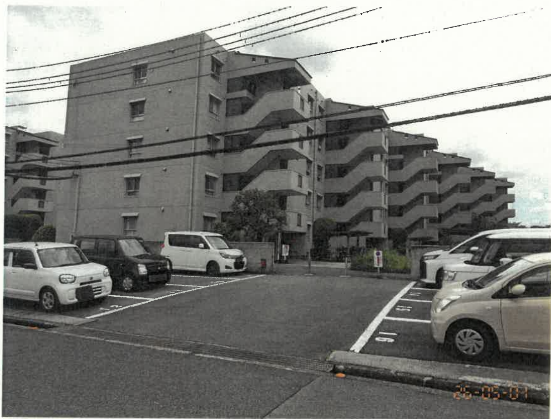
一棟の建物全景
