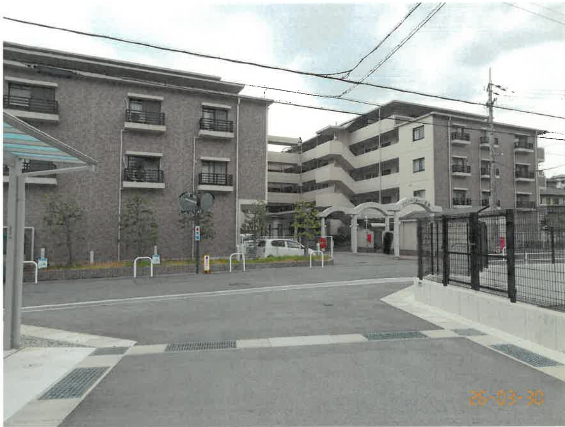
一棟の建物全景
