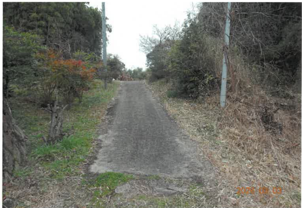
③ (目的外土地に設けられた進入路)
