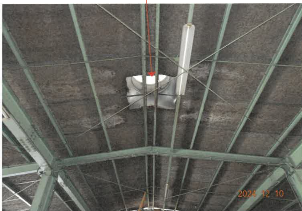
⑯ (2階天井 隙間から雨漏りがある換気扇)
