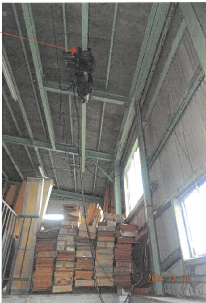
⑯ (2階天井 隙間から雨漏りがある換気扇)
