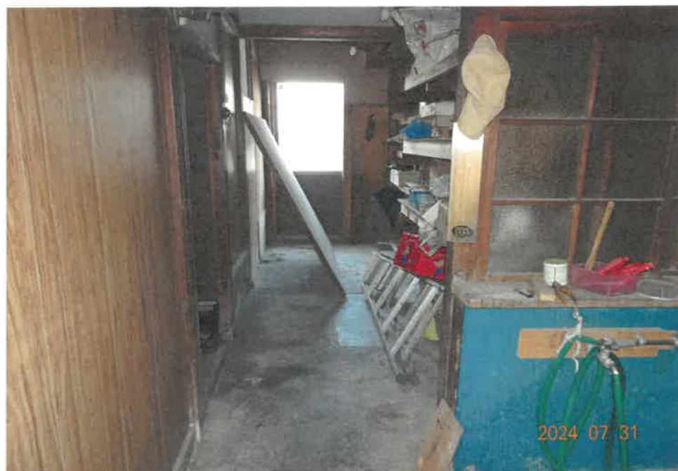
⑨ (附属建物 1 階東側 未登記増築部分)
