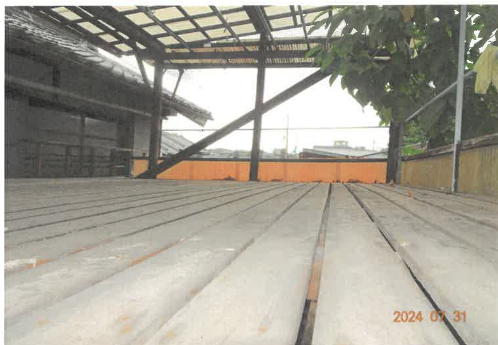
⑬ (主である建物1階屋根上 物干場)
