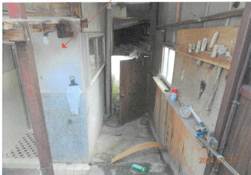
⑦ (主である建物 1 階未登記増築部分 WCの一部)
