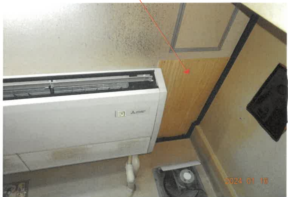
(物件9 店舗4 ①⑧ 雨漏り修復箇所)
