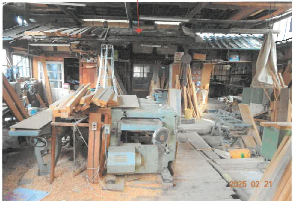
⑪ (物件 5 屋根瓦欠落箇所)
