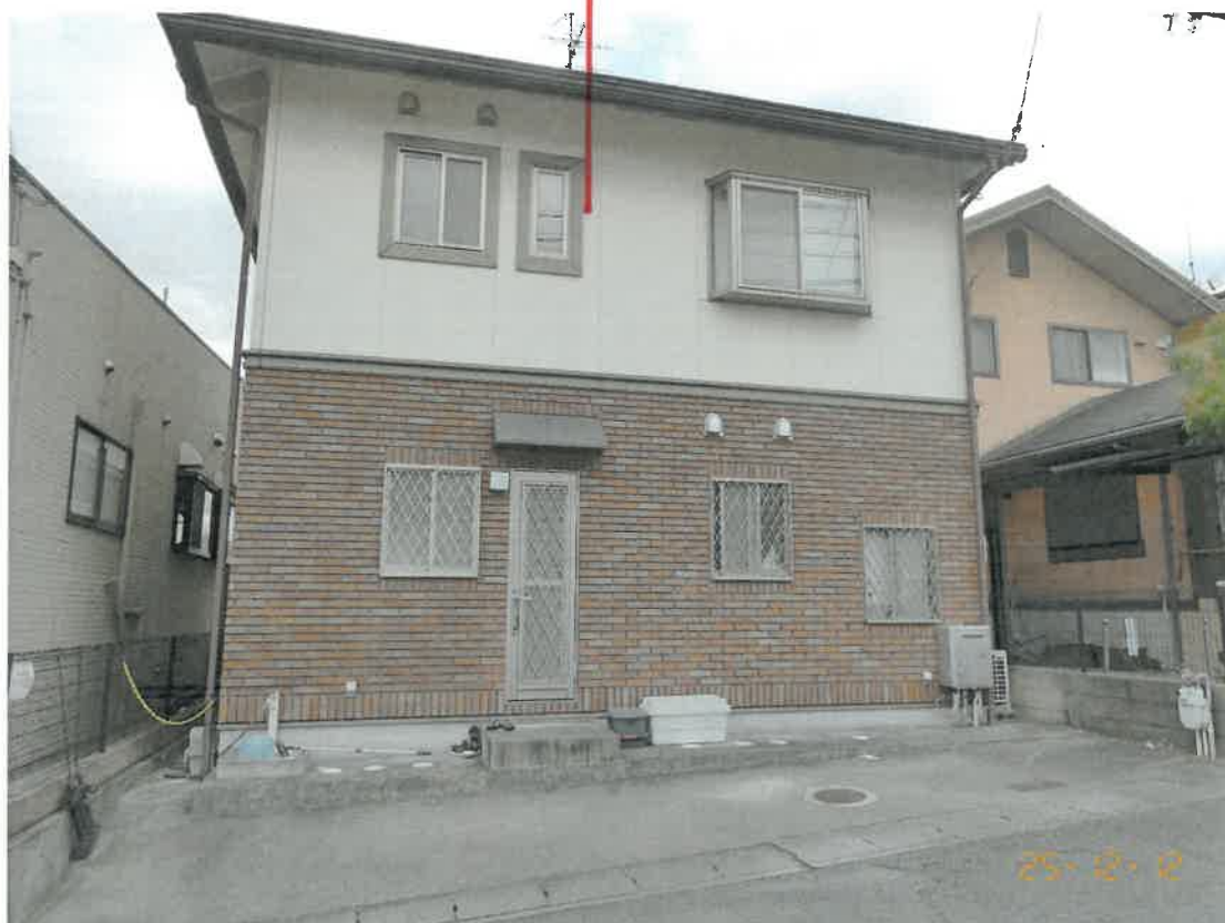
目的建物(勝手口側)
