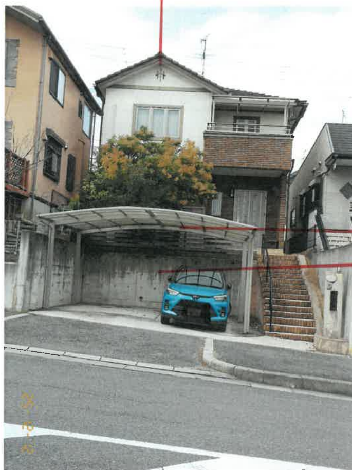
目的建物(玄関側)
