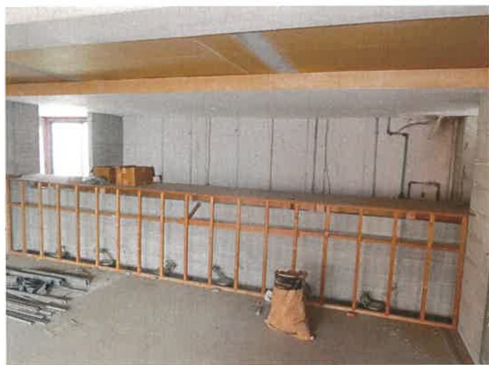
附属資料8 現況写真
