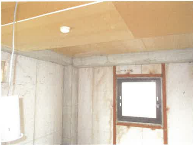
4階 店舗天井付近
