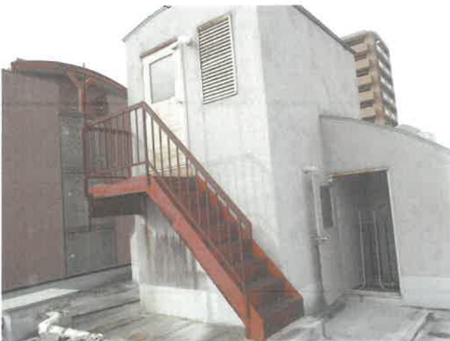
屋上 EV機械室
