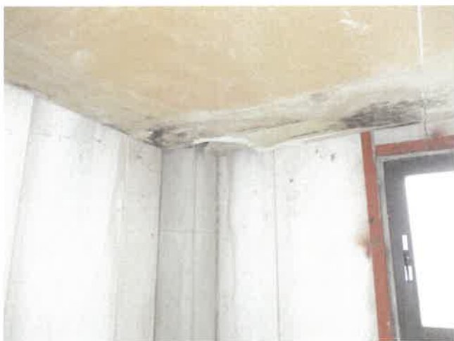
3階 店舗天井付近
