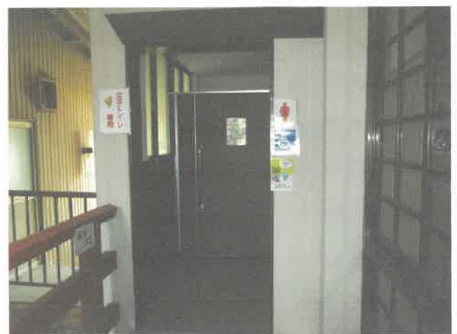
物件 5 主建物 1 階
