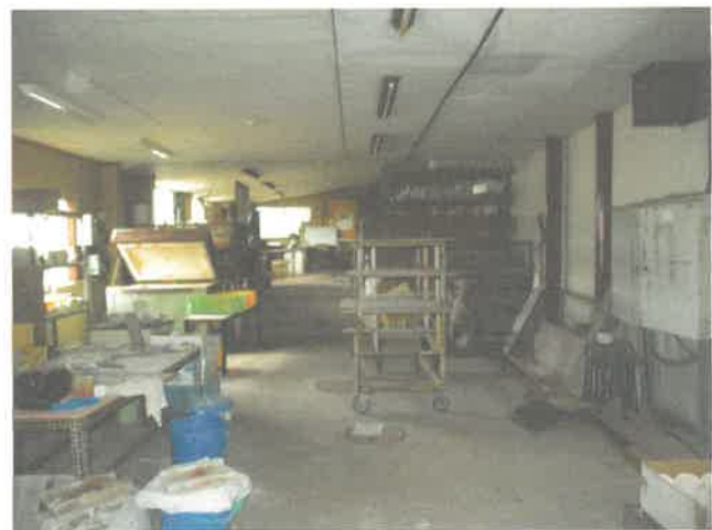
物件 4 主建物 1 階
