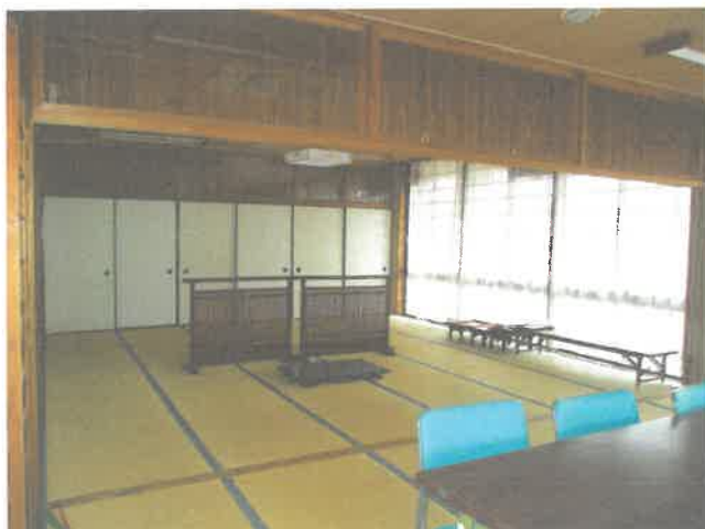
物件 5 主建物 2 階
