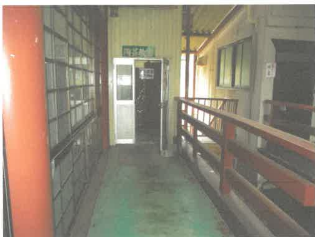
物件 4 主建物 1 階
