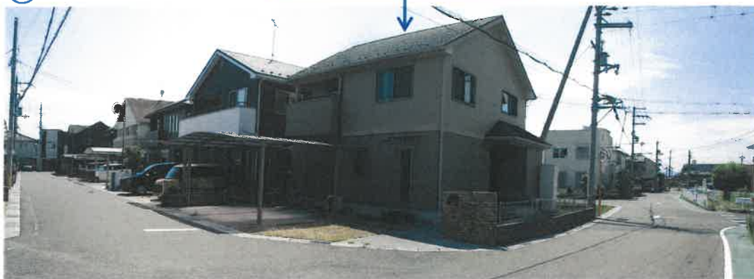
物件4 主である建物
