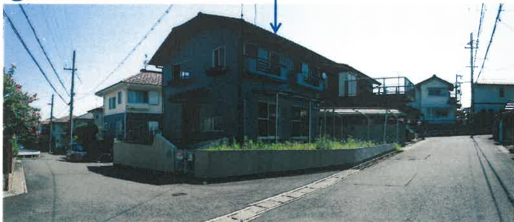
物件5 主である建物
