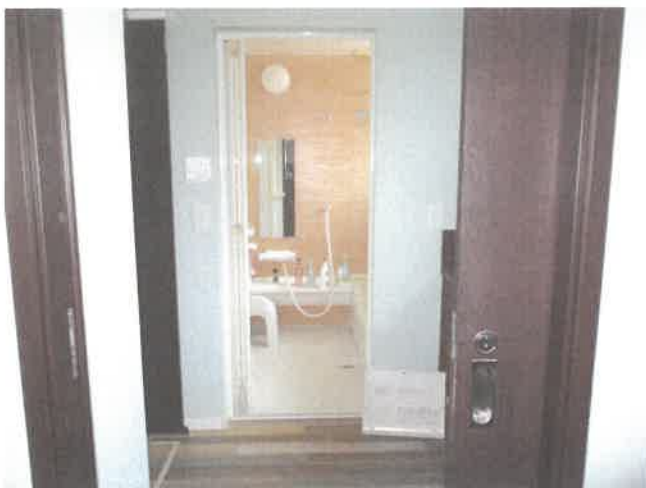
1階 洗面・浴室
