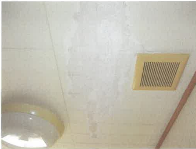
1階 洋室天井付近
