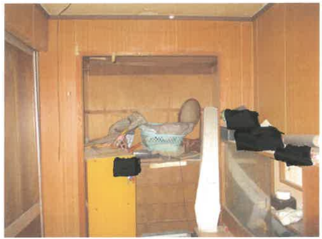
主建物 1階 板間
