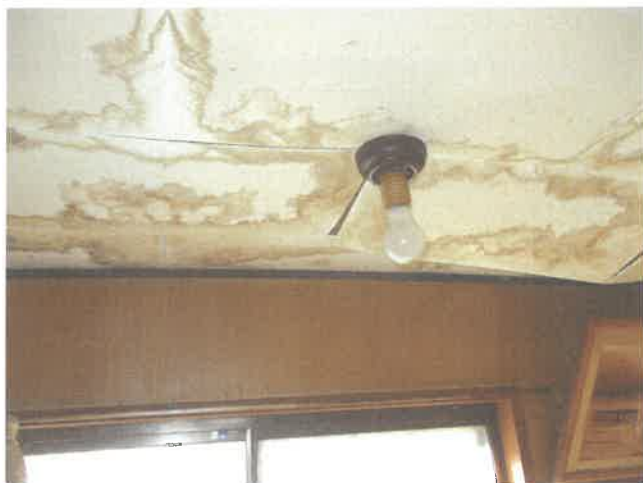
主建物 1階 ホール天井付近
