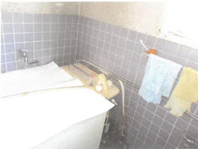
主建物 1階 浴室
