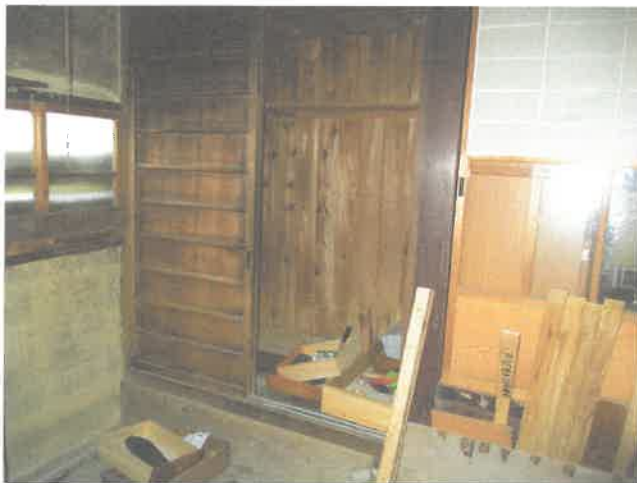
主建物 キッチン
