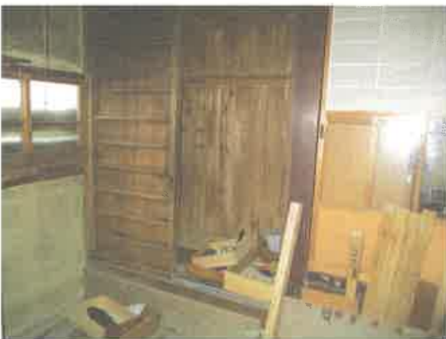
主建物 キッチン
