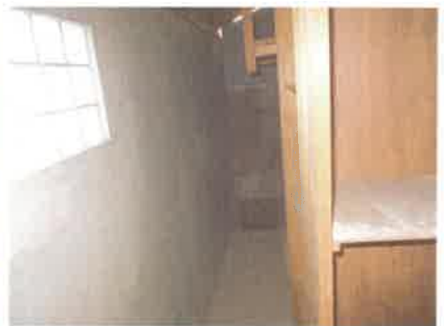
主建物 1階 通路
