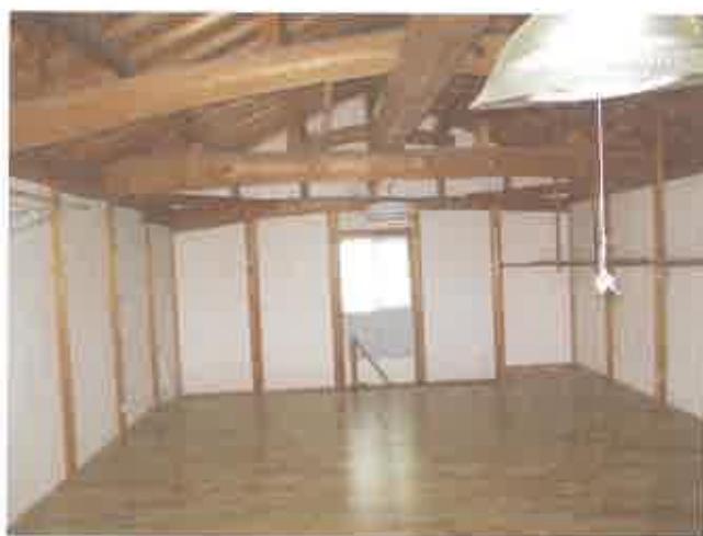
主建物 2階 板間
