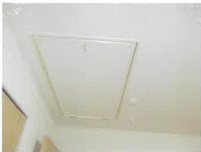
屋根裏収納入口
