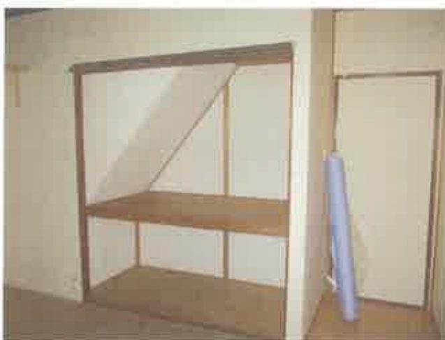
主建物 1階 和室
