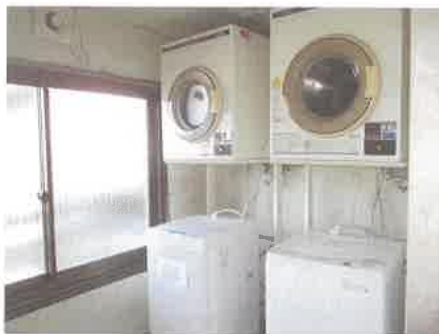
1階 ランドリー室
